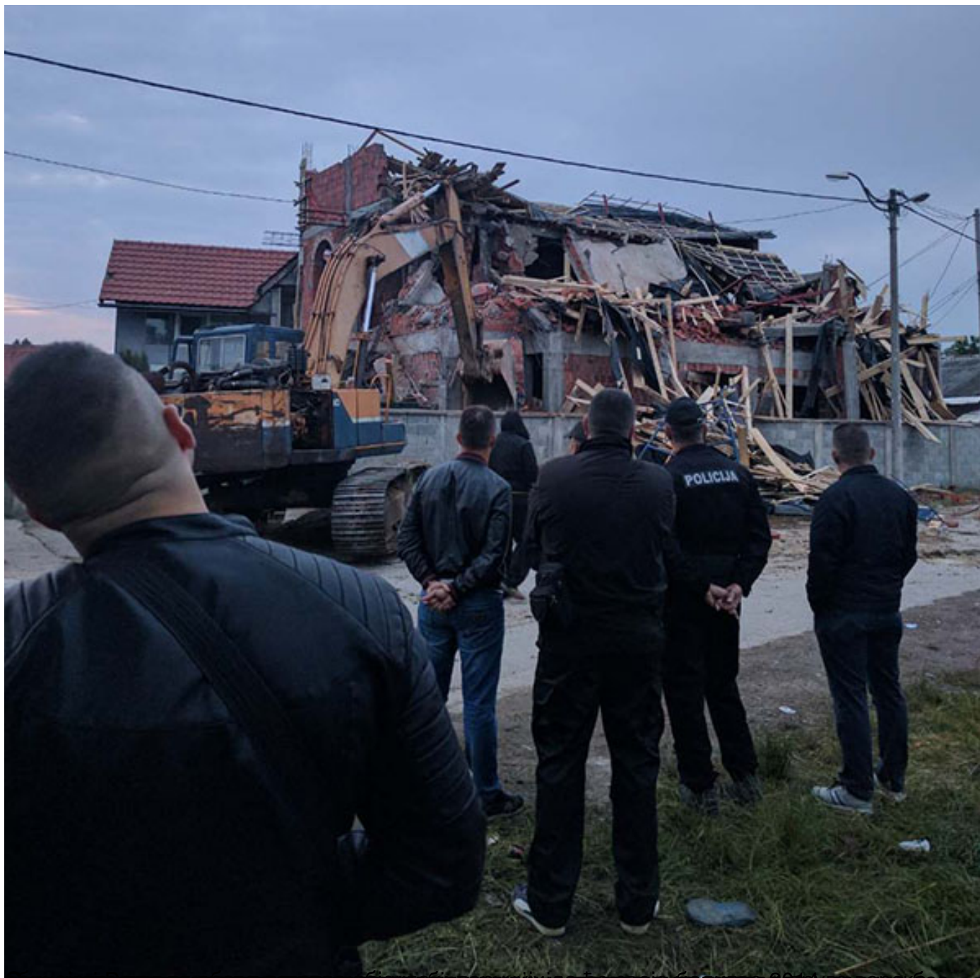
Исламски верски објекат у Земун пољу, који је изграђен без дозволе, срушен је у петак, 26. маја 2017. године. На слици се види како је објекат срушен.
